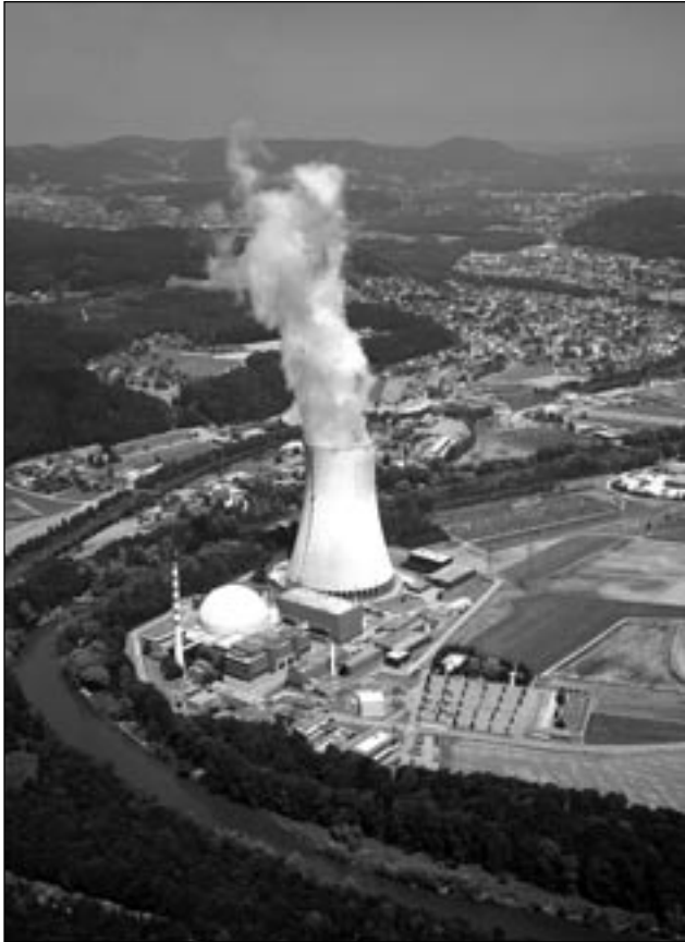
Атомна електростанція в Гьосен-Данікен в Швейцарії Джерело: www.nagra.ch , 2007
